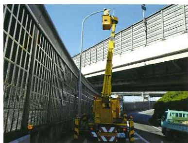
道路照明設備点検
