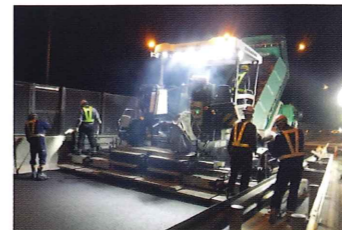
舗装補修工事
