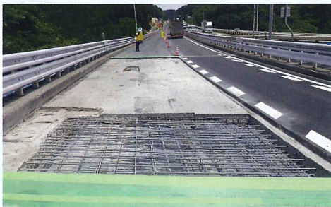
橋梁の舗装下のコンクリートを補修します。
