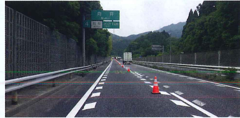
〔維持修繕工事〕
