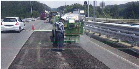
〔橋梁補修工事〕
