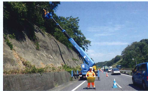
舗装、区画線の補修や樹木の伐採を実施します。
