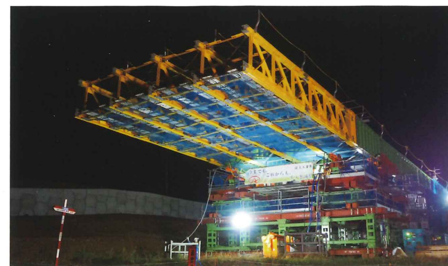
橋桁の送出し施工例
