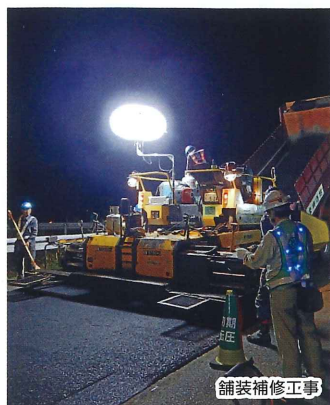
舗装補修工事
