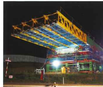
橋桁の送出し施工例①
