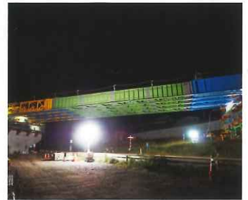
橋桁の送出し施工例②
