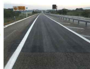
路面補修(施工後)
