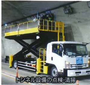
トンネル設備の点検・清掃
