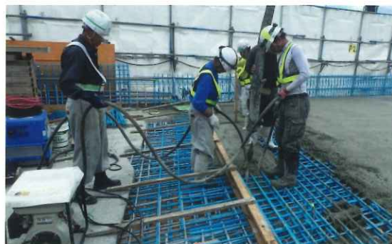
現場打ち床版の施工状況
