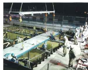
新しい床版の設置
