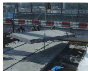
老朽化した床版の撤去
