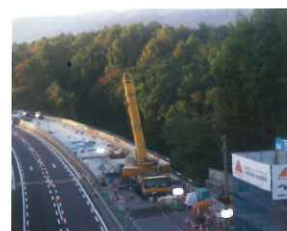
床版取替工事 全景
