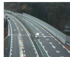
床版取替完了後
