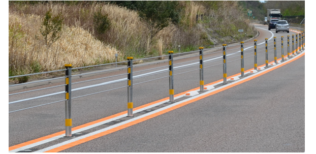
ワイヤーロープ設置状況(イメージ)
