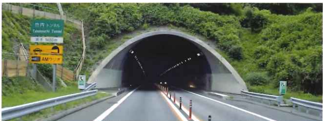
竹内トンネル
