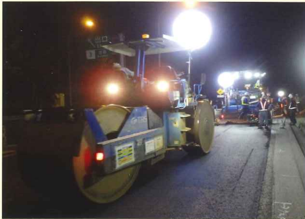
舗装補修工事
